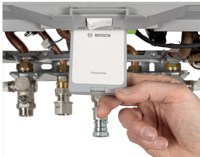
► Figuur 5: Het key-slot met de K 30 RF-module
